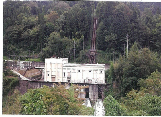
⑦ 真弓発電所 5,600Kw 水路総延長 4,369m 有効落差 176m
