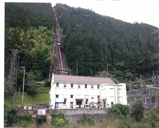
⑩ 上村発電所 10,400Kw 水路総延長 7,976m 有効落差 306m
