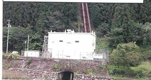
② 島発電所 1,800Kw 水路総延長 3,316m 有効落差 49m
