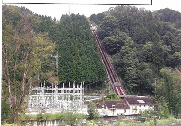
⑥ 下村発電所 4,700Kw 水路総延長 4,455m 有効落差 84m
