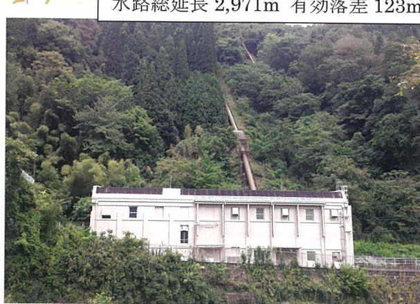
⑧ 押山発電所 3,800Kw 水路総延長 2,971m 有効落差 123m
