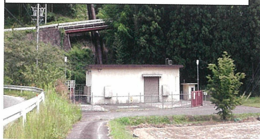
③ 飯田洞発電所 660 Kw 水路総延長 1,526m 有効落差 42m
